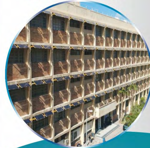
مبنى كلية العلوم بالشاطبي الألواح الشمسية الشفافة واجهة جميلة للمبنى
